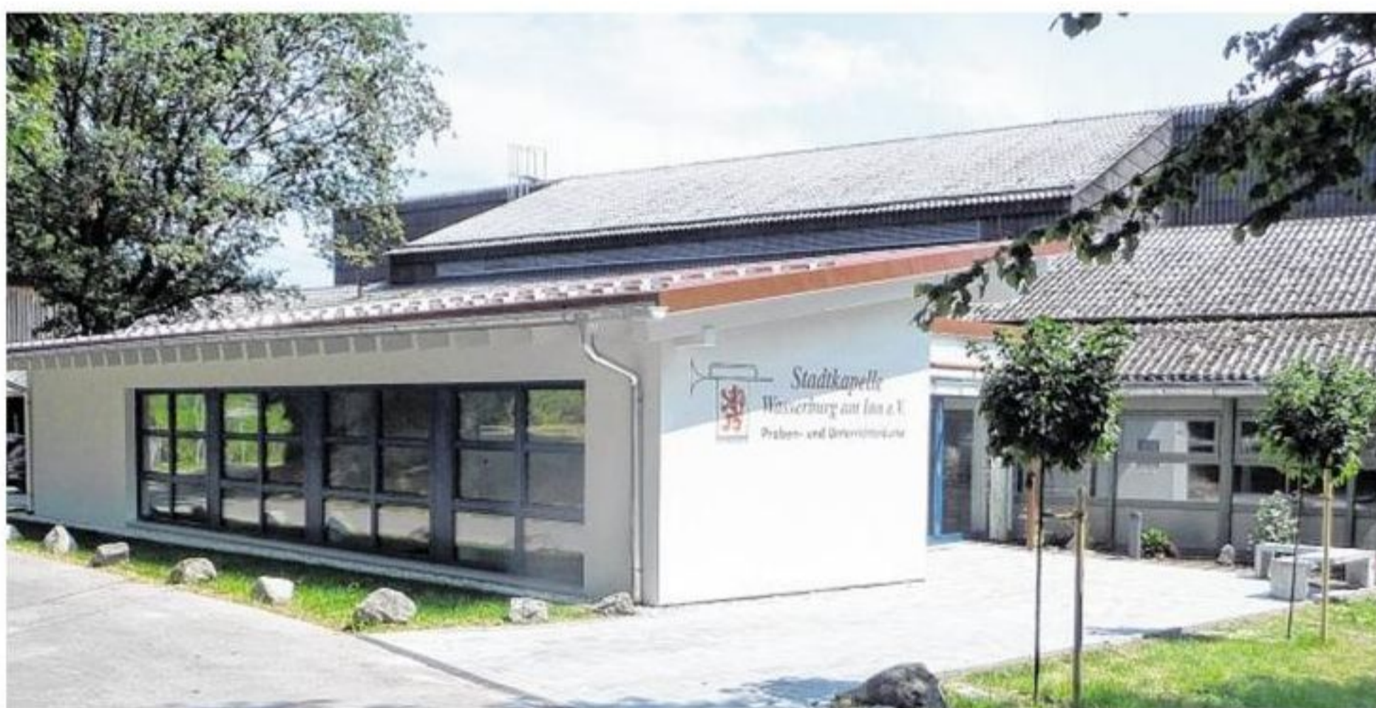
Das erweiterte Vereinsheim bietet nun den notwendigen Platz für den umfangreichen Proben- und Unterrichtsbetrieb.
