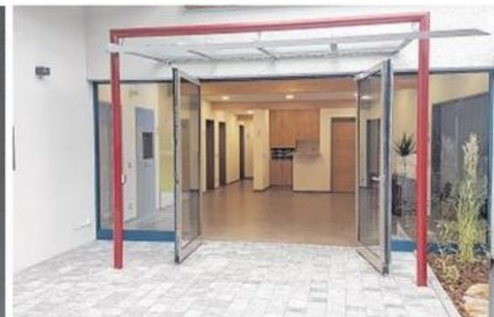
Der moderne Eingangsbereich zum Probenraum.
