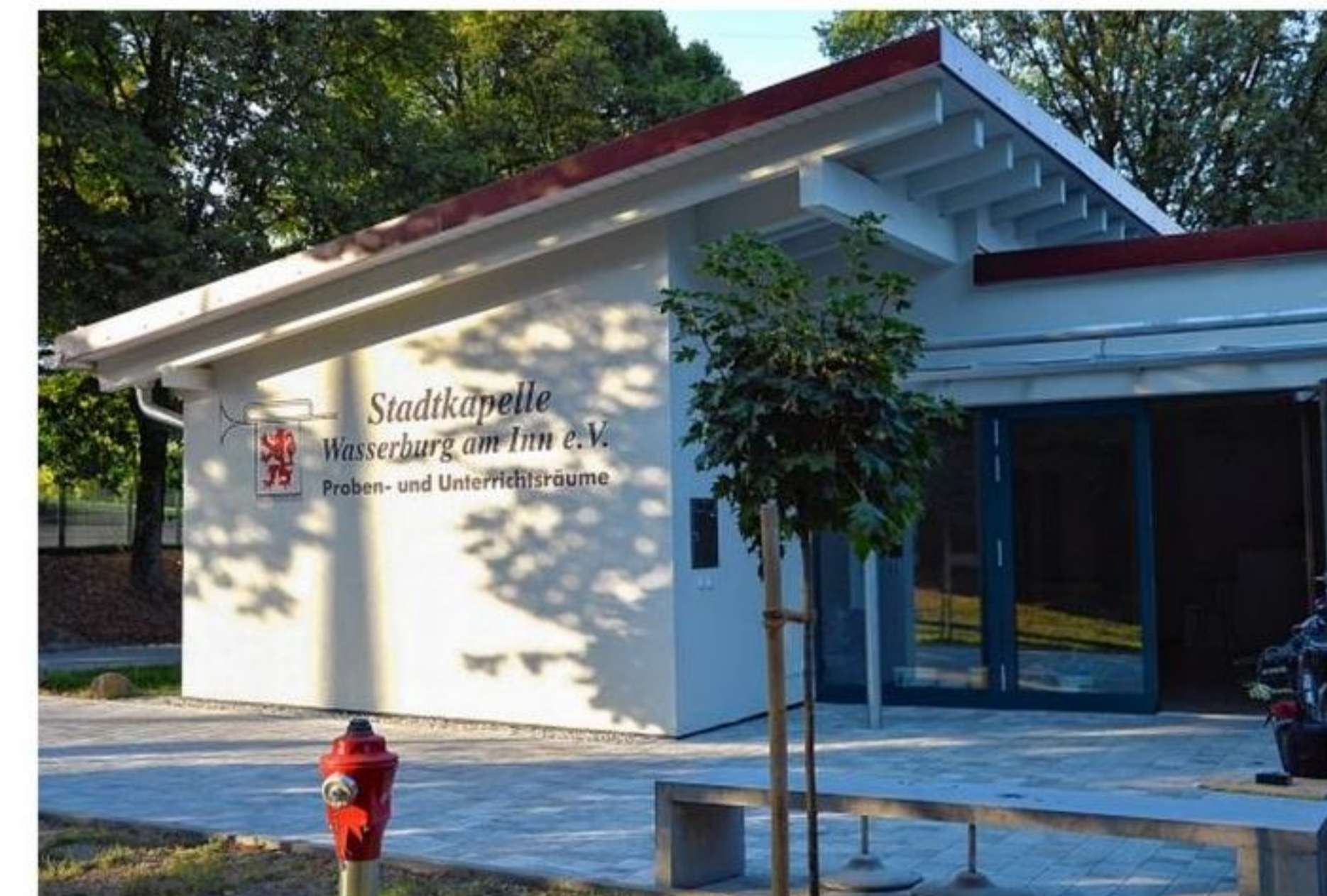
Die Erweiterung des Vereinsheimes der Stadtkapelle am Badria sieht schon sehr fertig aus, selbst drei Bäume neben der Zufahrt sind bereits gepflanzt.
