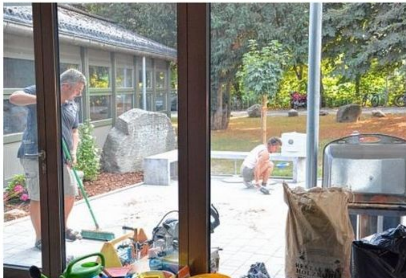
Aufräumen und Putzen, das ist auf der Baustelle der Stadtkapelle immer wieder Programm, denn der Betrieb läuft weiter.
